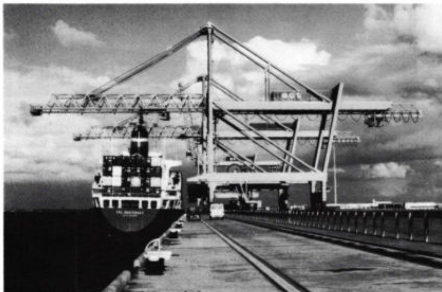
Siemens leverde voor 11 containerkranen de complete elektrische installatie, inclusief de montage en inbedrijfstelling.
